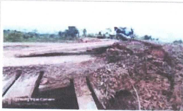
FOTO 03: Ponte na estrada do Cristal
